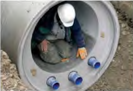
Figure 22 : Canalisation préfabriquée avec échangeur de chaleur intégré
