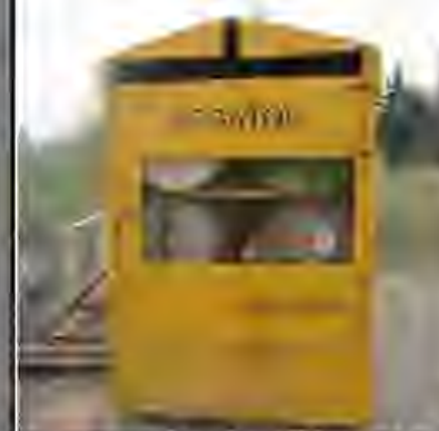
armoire équipée d'un bac de rétention
